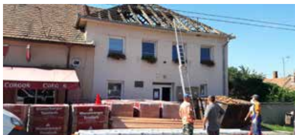
Kultúrny dom Chyzerovce počas rekonštrukcie.
