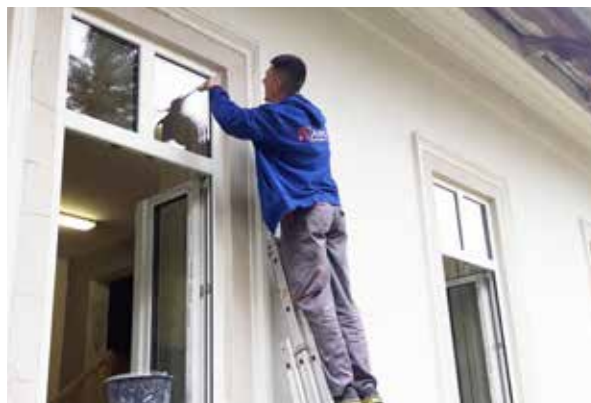
Montáž nových okien na kultúrnom dome.
