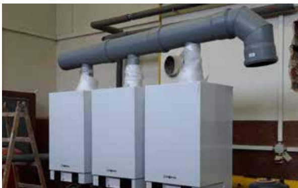
Počas inštalácie nových kotlov.
