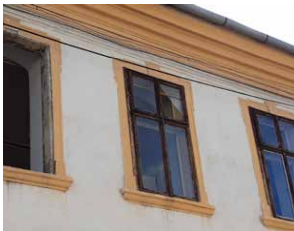
Budova MSKŠ počas rekonštrukcie.
