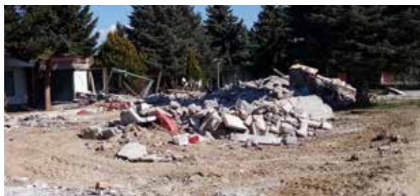
Počas búracích prác.
