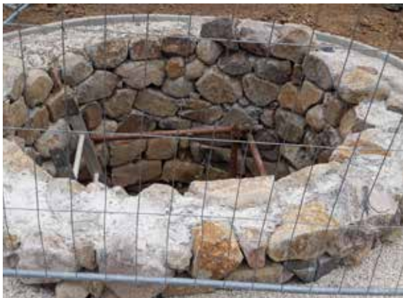
Stav rekonštrukcie studne v posledný júnový deň.
