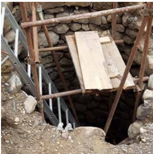
Po odstránení betónovej platne.
