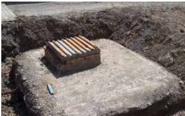
Studňa pred odkrytím betónovej platne.
