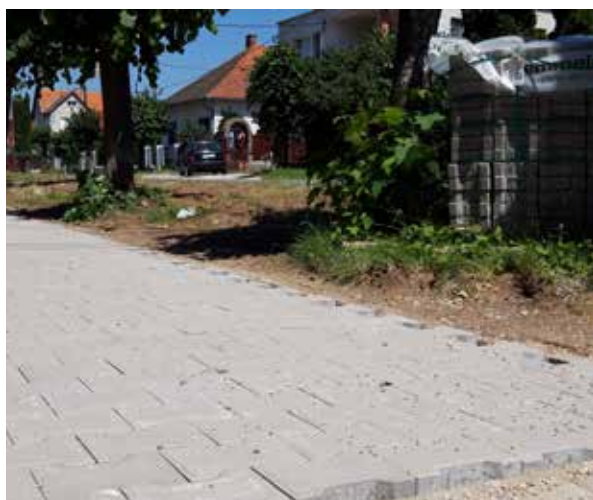
Chodník tesne pred ukončením stavebných prác.
