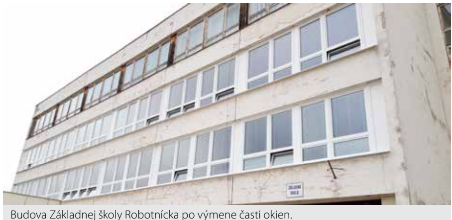
Budova Základnej školy Robotnícka po výmene časti okien.
