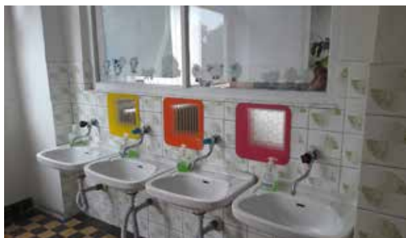
Jedna z detských kúpeľní pred rekonštrukciou.
