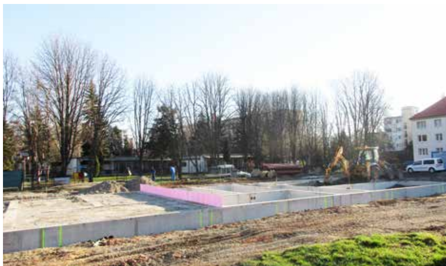
Základy novej bytovky na Ulici 1. mája.
