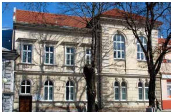
Budova ZUŠ-ky na Župnej ulici.
